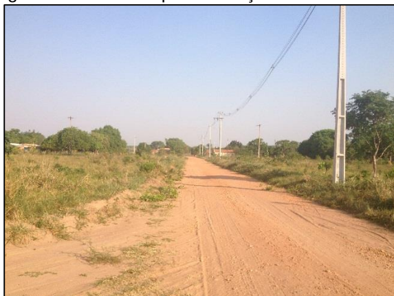
Figura 22 – Falta de pavimentação nas ruas
